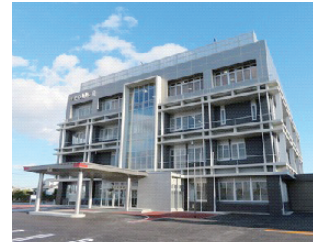
完成間近となった浜松西警察署
